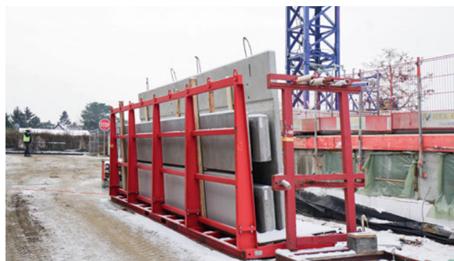
Die im Werk mittels BIM hergestellten Fertigteile werden zum Montage-termin angeliefert.
