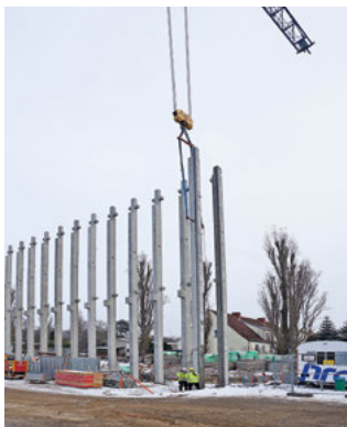
Per Kran werden die Stützen in die Köcher mittig eingehoben.
