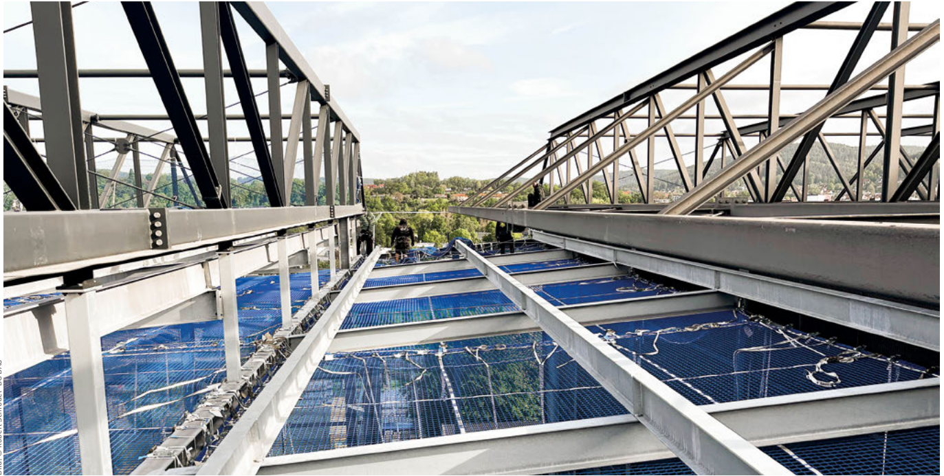
Arbeitsplattformnetze können als Arbeitsplätze und Verkehrswege verwendet werden und abstürzende Personen auffangen.
