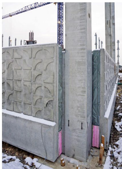
Unkomplizierte Montage der Fassadenelemente
