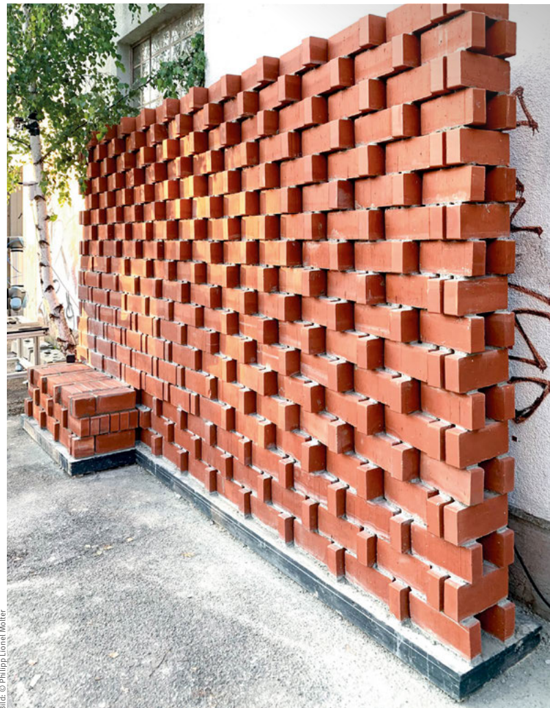
Beim CAB-Projekt verschatten sich die Ziegelsteine durch ihre besondere Anordnung selbst bei Sonneneinstrahlung.
