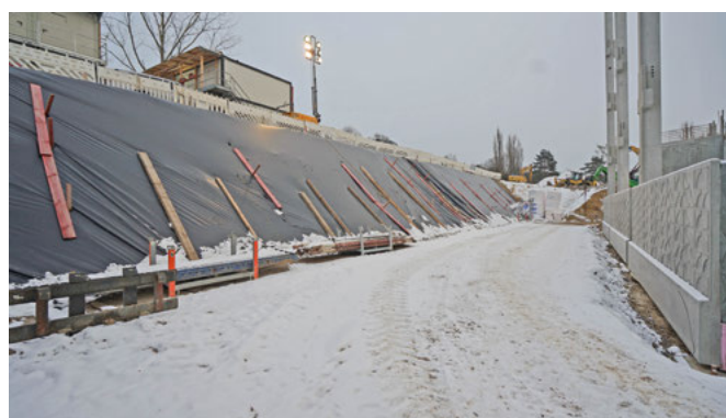
Böschungssicherung des 10 m hohen Gefälles zwischen Hang und Erdgeschoss
