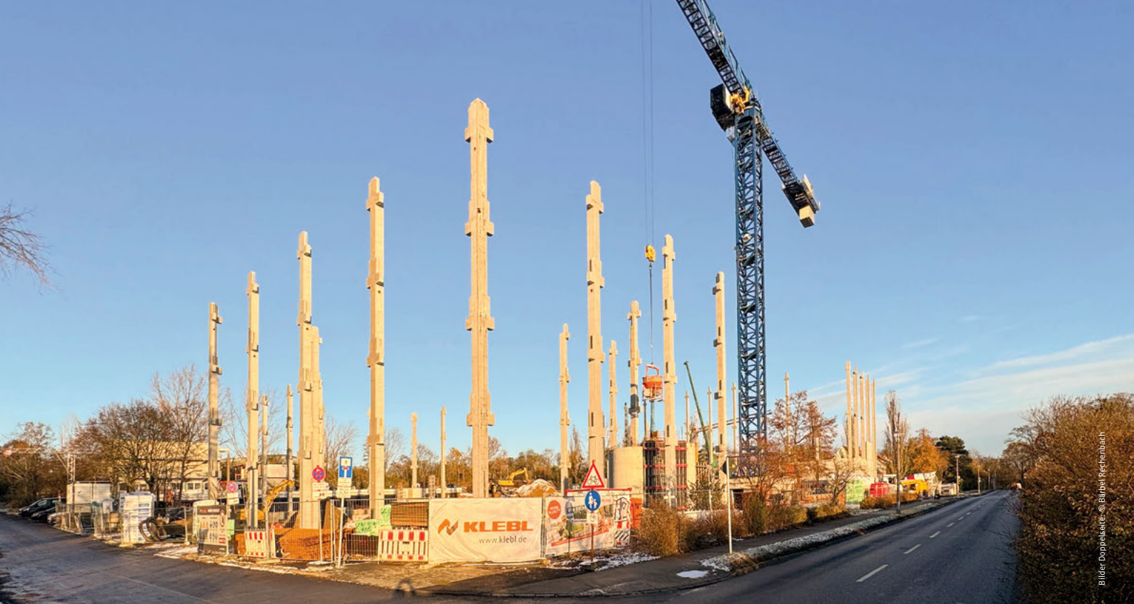
Betonage eines Treppenhauses
