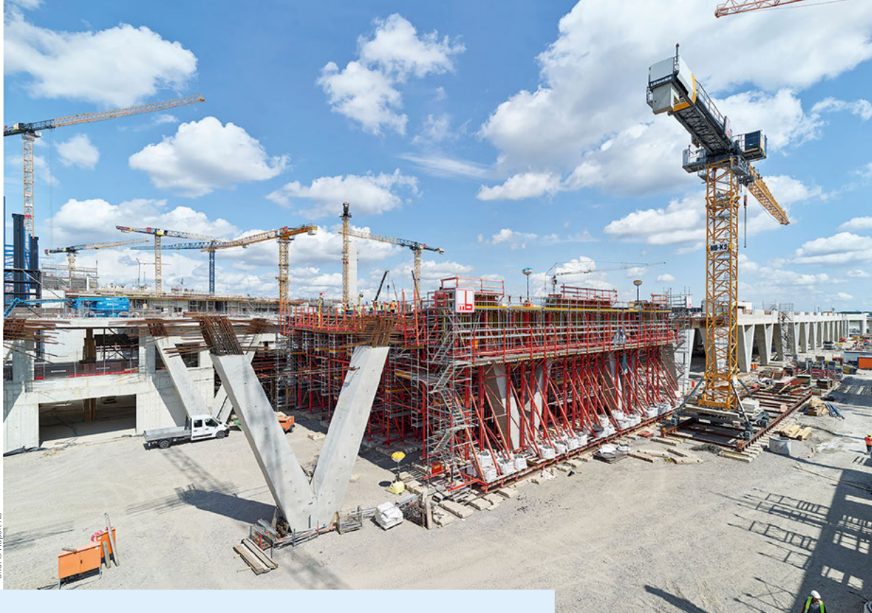
Der Vorfahrtstisch steht auf 70 vor Ort gegossenen V-Stützen, die auf Pfahlgründungen gelagert sind, und umfasst eine Fläche von 15.300 m 2 .
